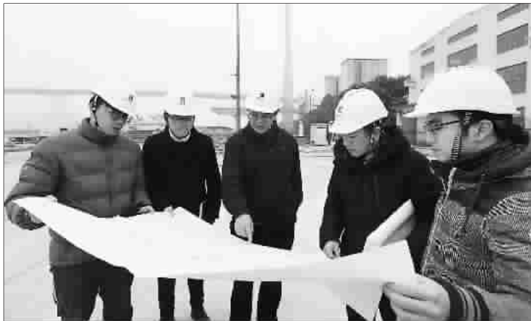
杨浦滨江杨浦大桥以东2.7公里正在紧张施工中，图为刘安（中）在广德路码头施工现场了解工程建设情况。（资料照片） ■摄影 王修远
